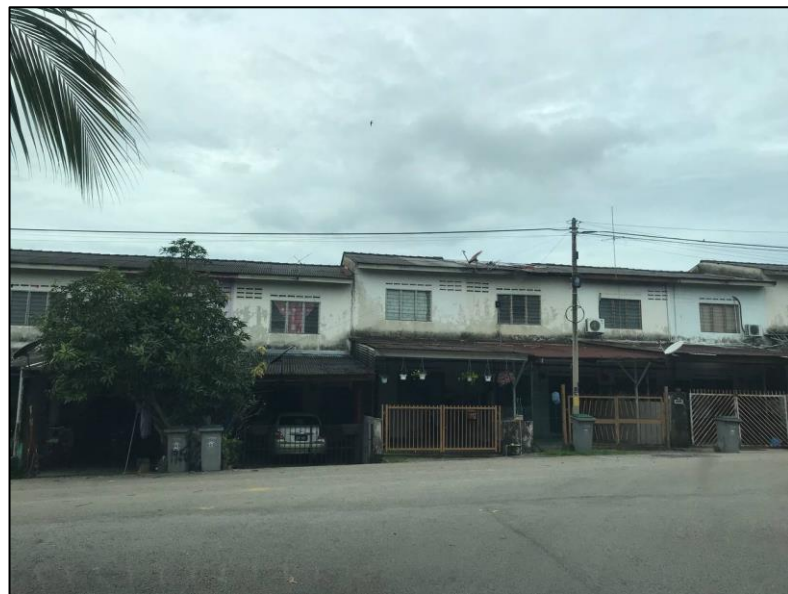
Rajah 18: Rumah yang tidak mempunyai dinding pemisah
