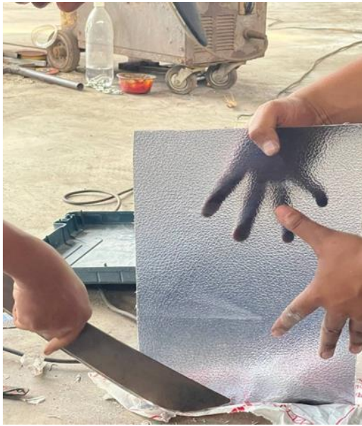
Rajah 3.10.11 Membuang sticker pada polycarbonate
