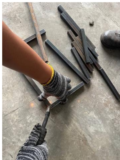
Rajah 3.10.9 Proses mengimpal rangka pintu
