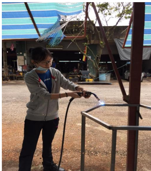
Mematerikan besi untuk membuat kerangka produk
