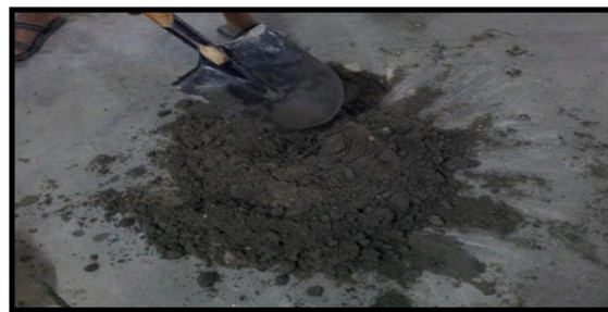
Rajah 3: Proses Menggaul Campuran Bata
