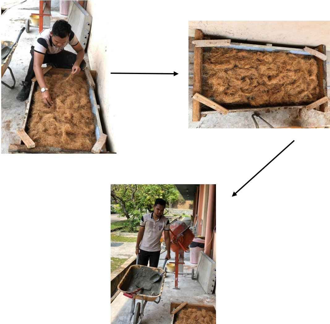
Rajah 3.4.1 vi : Tuangkan Siem dan Letakkan Sabut Kelapa
