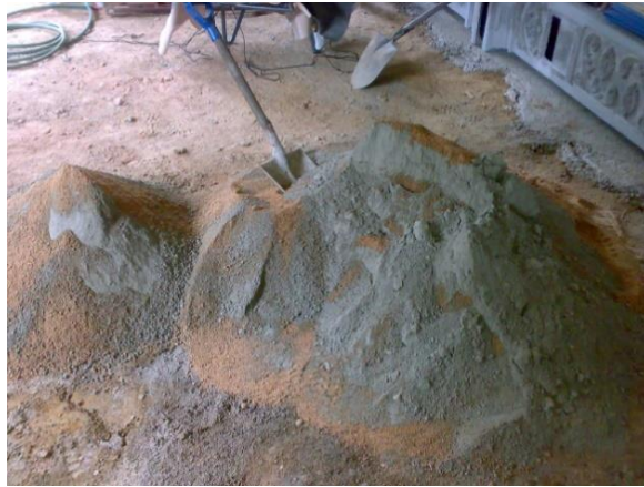
Rajah 3.4.1 iii : Gaulkan simen dan pasir sehingga sebati
