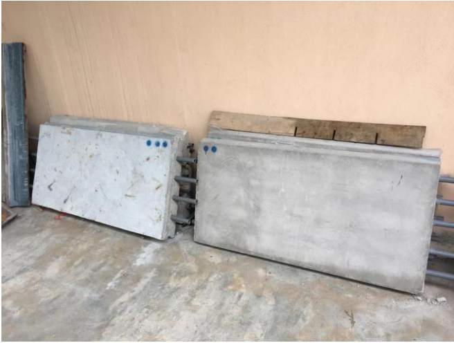
Rajah 3.4.1 viii : Label Panel Dinding Mengikut Nisbah Bacaan yang Ditetapkan
