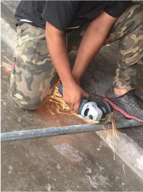
Memotong paip besi GI
