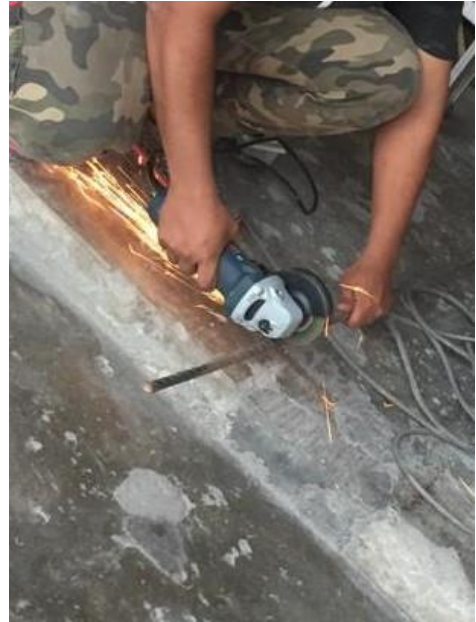
Memotong besi beton ulir
