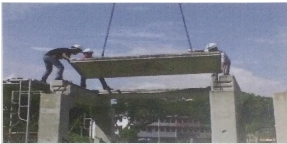
Rajah 2.4 Komponen slab dipasang ke rasuk dan tiang
