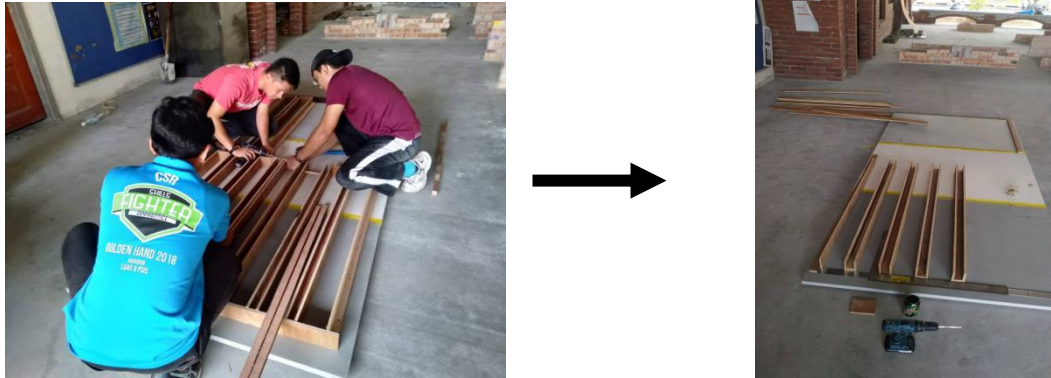
Rajah 3.4 Pemasangan dan penyambungan Acuan
