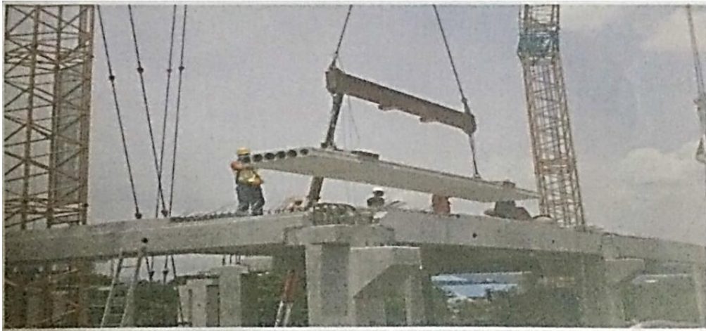
Rajah 2.3 Komponen dipasang menggunakan kren
