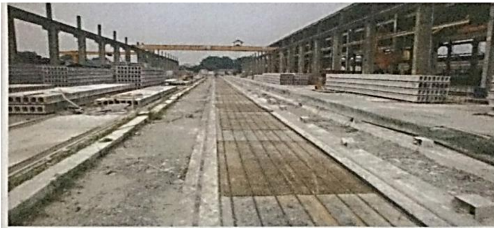
Rajah 2.1 Komponen dibuat di kilang atau di tapak pembinaan
